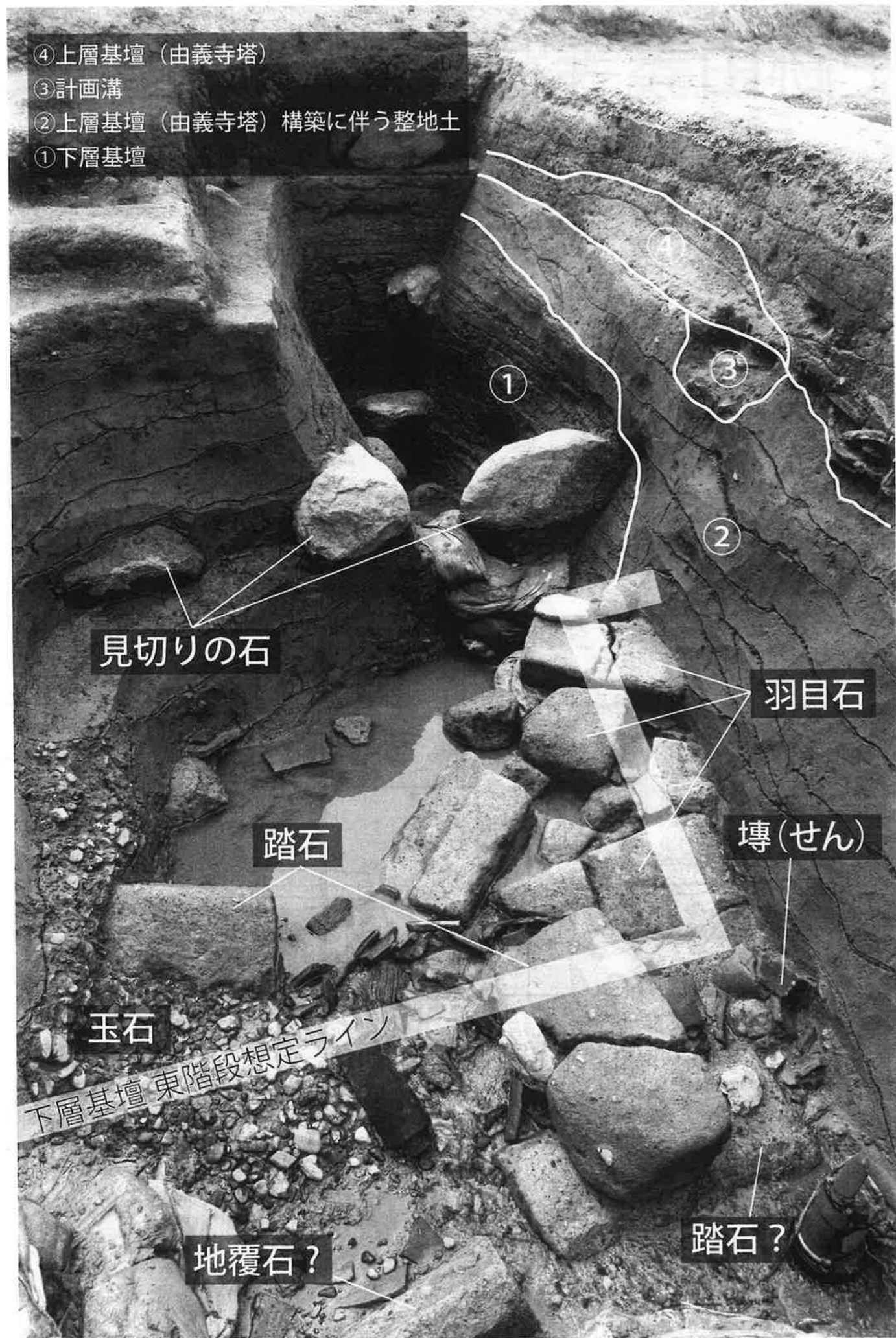
【南区】上層・下層基壇、下層基壇外装材の検出状況 (東から)
